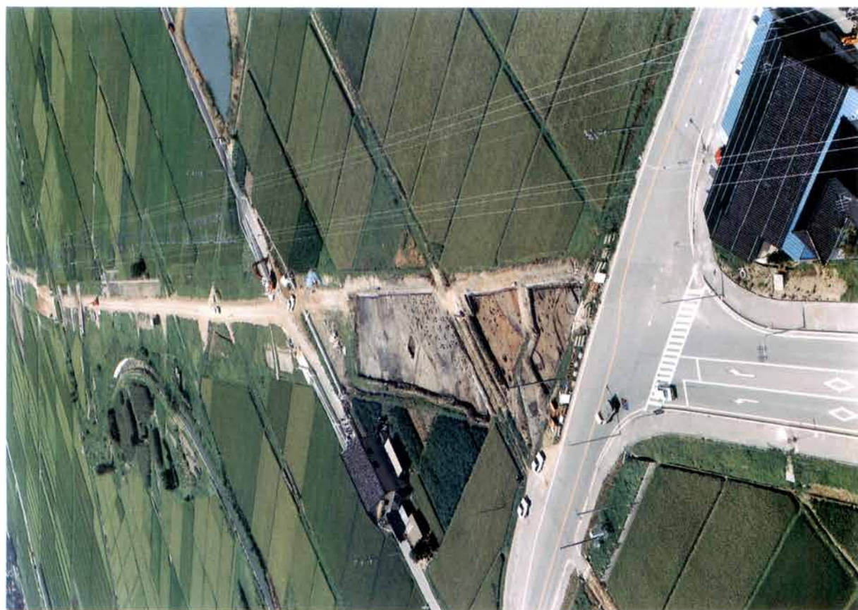
2. 航空写真4 (北東より)
