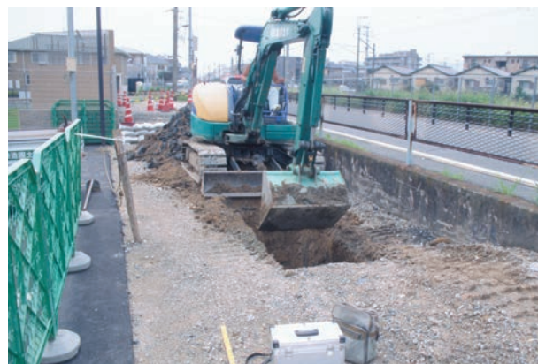
第 48 次調査 4 トレンチ状況（北東から）
