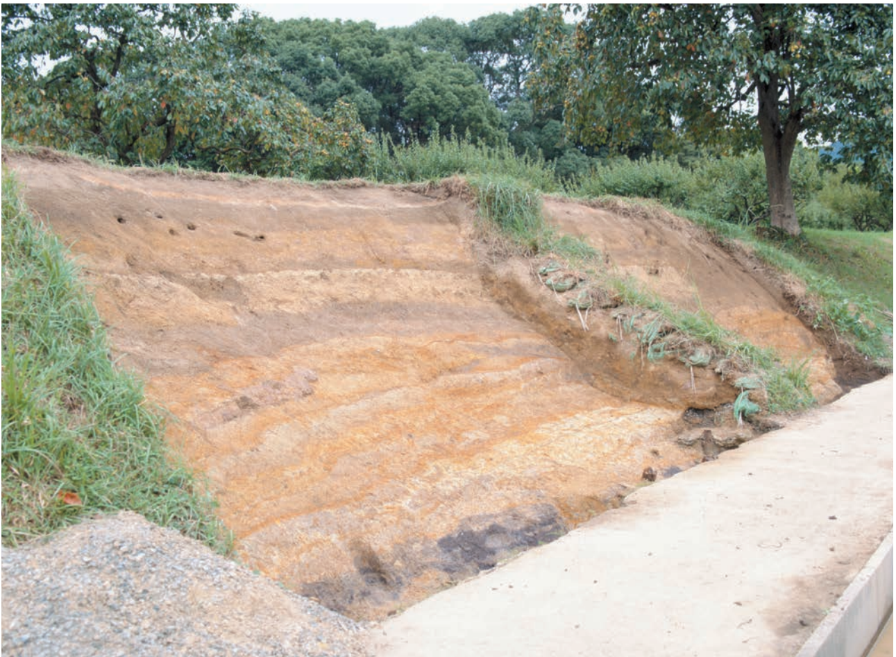
第 49 次調査 B 区 土層状況（南西から）
