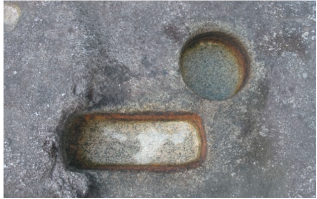
1、東門礎石の軸摺穴と方立穴
