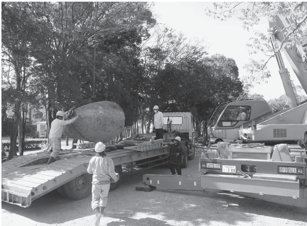
推定朱雀門礎石移設作業風景
