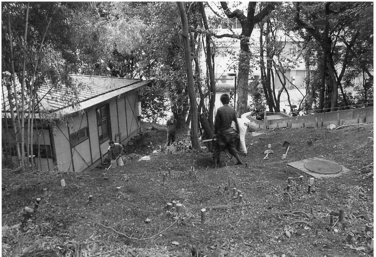
2 東区伐開後状況
