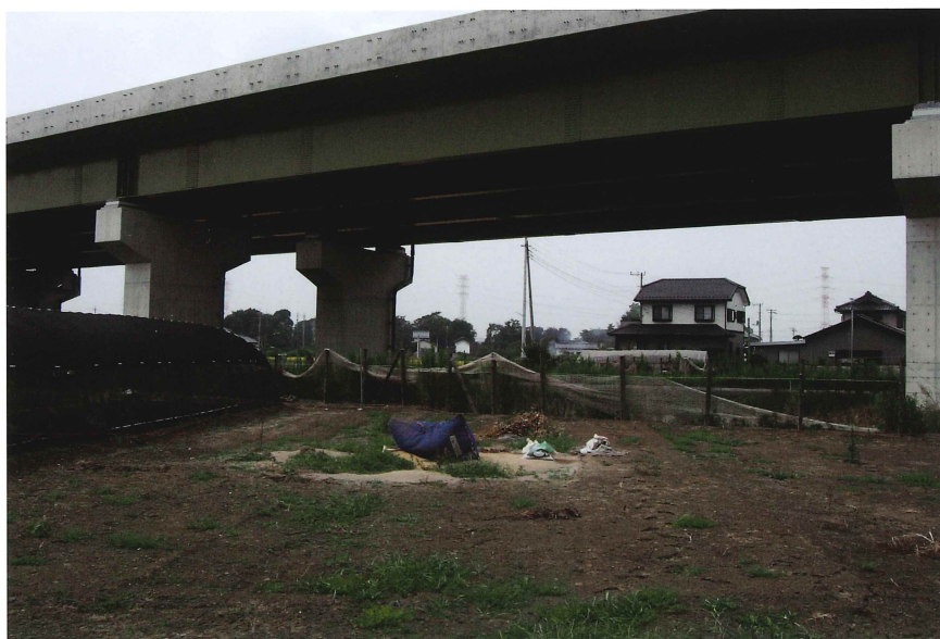
3 A区現況 (平成21年9月)
