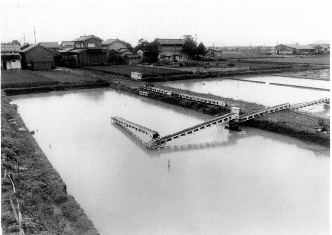
梅雨時溜水状況写真(北東側より)
