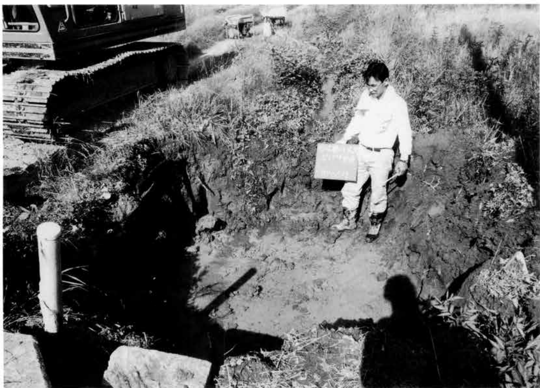
盛土保存地区ポンプ場予定地試掘調査
