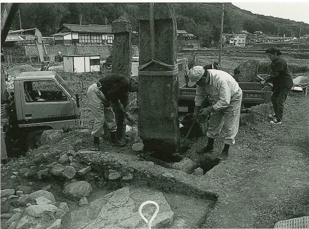
11. 板碑移設作業風景（南西から）
