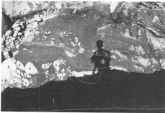
堤体断面3 (山側・立面図②-1付近) 1層 10YR2/2・黒褐色 ・縮まり疎 ・粘性なし ・腐食土 2層 4/3・鈍い黄褐色 ・ ・ ・ 3層 4/2・灰黄褐色 ・やや密 ・ ・砂 4層 4/3・鈍い黄褐色 ・ ・ ・砂質シルト 5層 4/2・灰黄褐色 ・密 ・ ・砂及び礫 ※5層より下は、巨礫と石英粗面岩質の山体基盤岩となっている。
