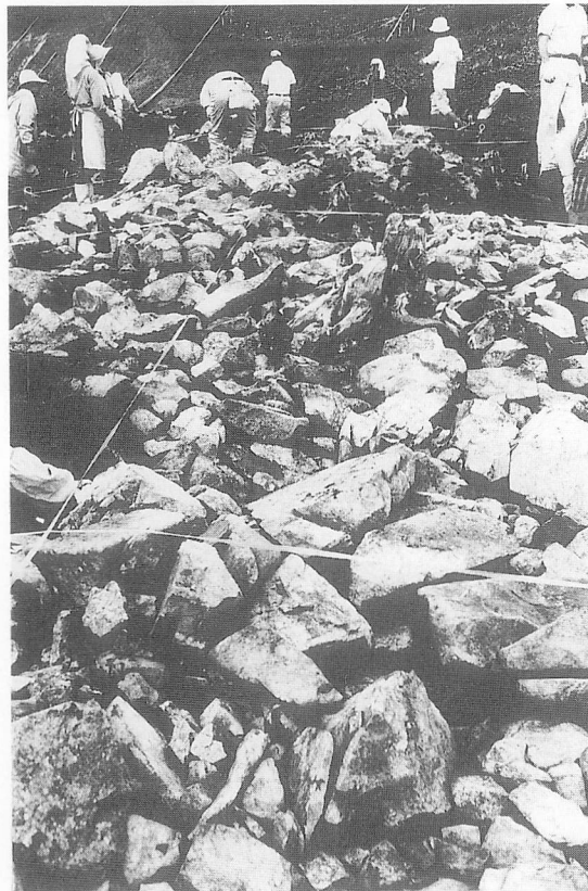
積石除去作業風景
