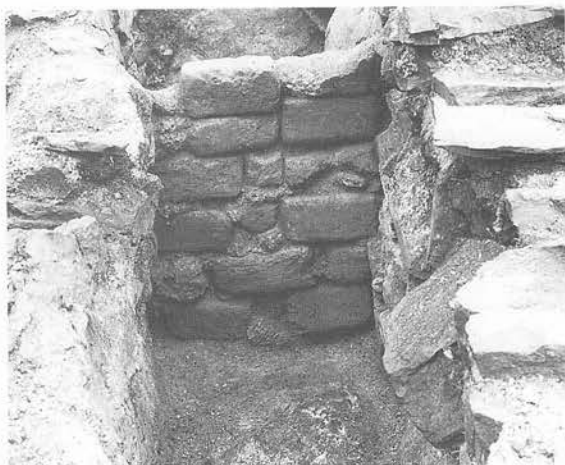
小舟と跡坪の仕切(北側)
