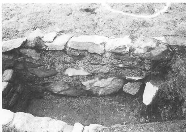
外側の石組(南壁西側)
