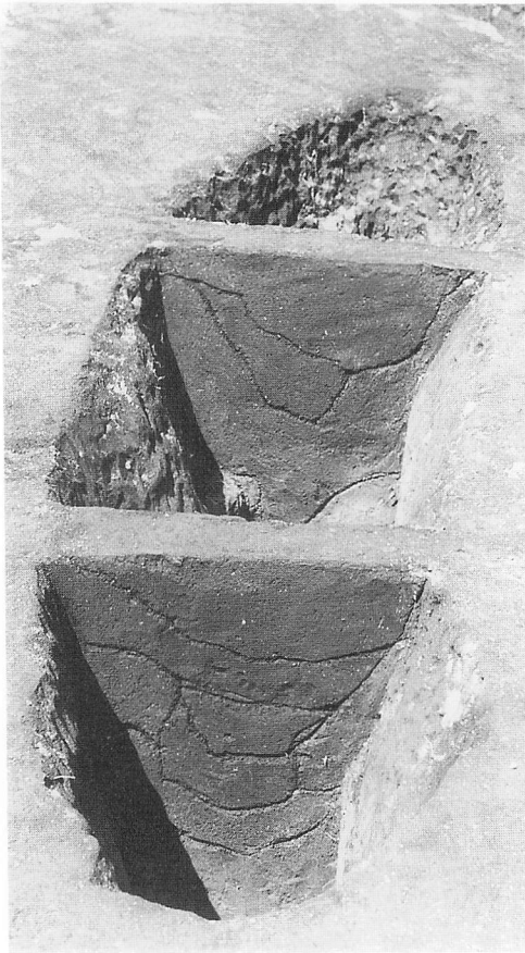
H II 陷し穴状遺構土層断面
