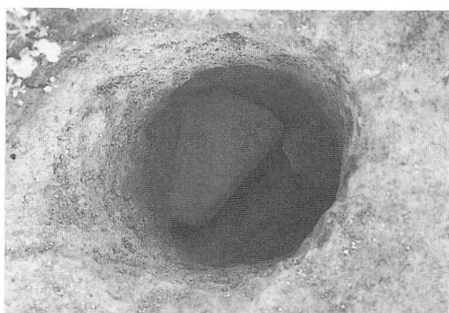
中央ピット底部
