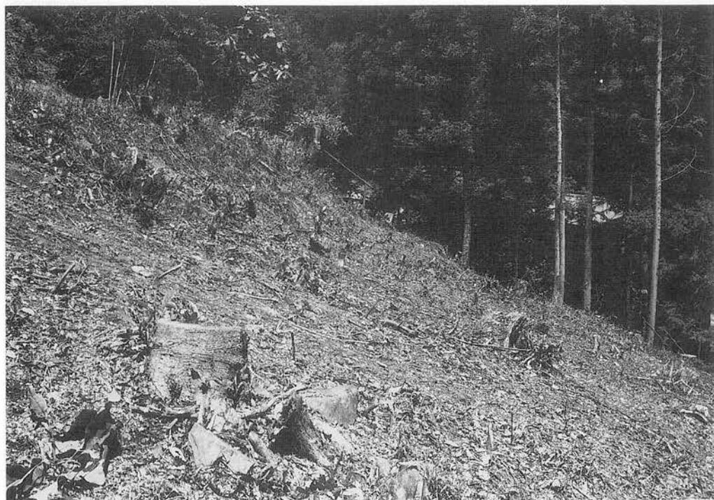
東側二段目平場 現状(Ⅱ区)南から
