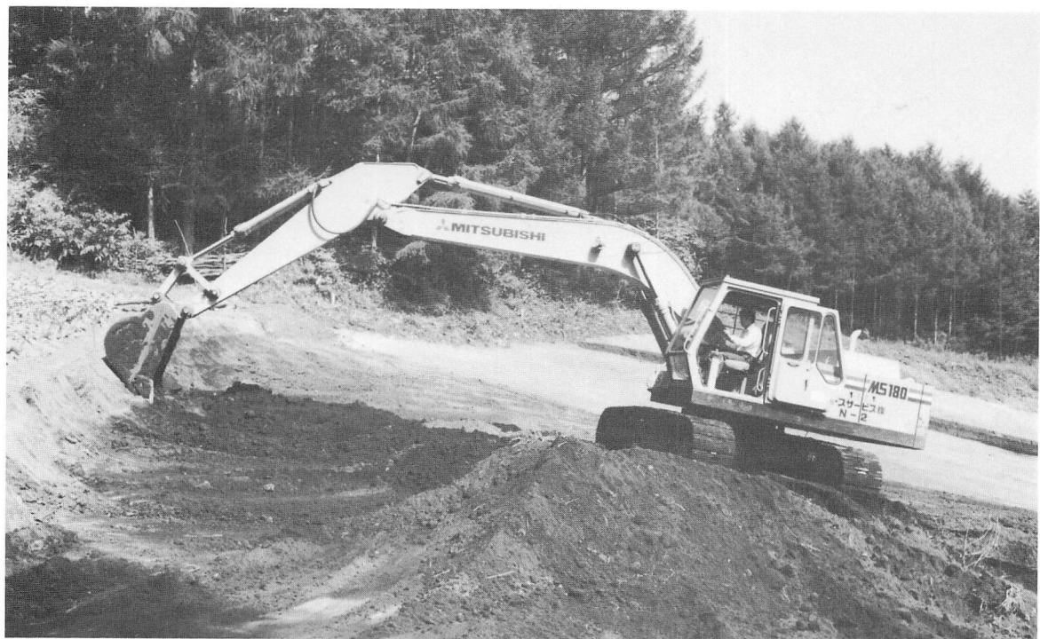
A 重機による粗掘り作業中
