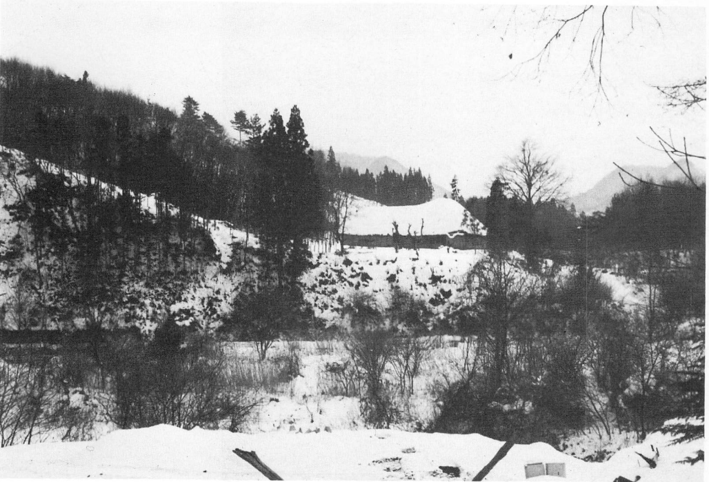
写真図版1 ダム完成後遺跡全景、曲り家遠景
