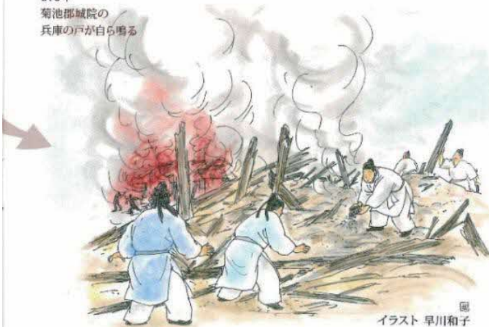
不動倉11棟が火災で焼失
