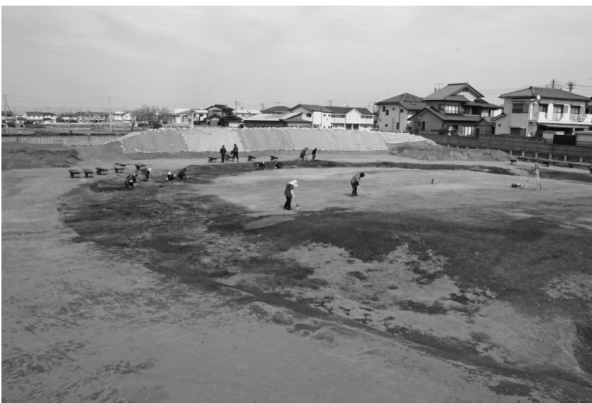
作業風景 南西から
