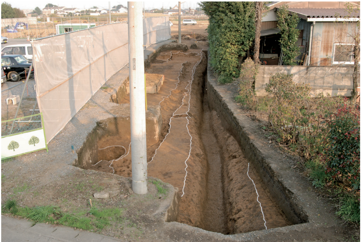
北堀久下塚北遺跡D 2 地点全景
