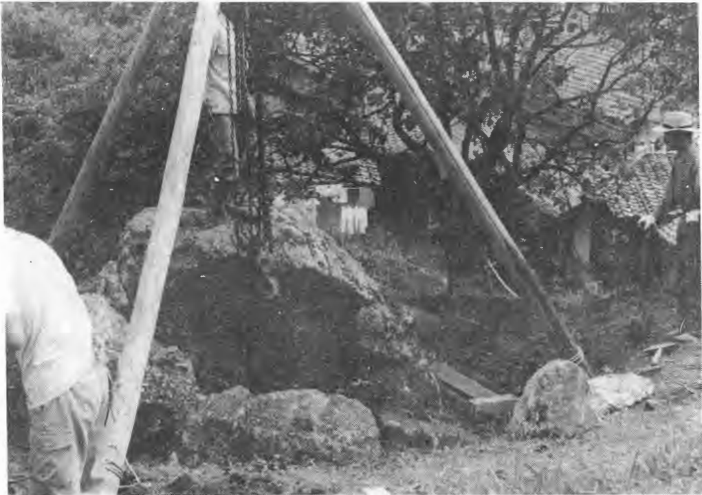
天井石をチェーンブロックであげる
