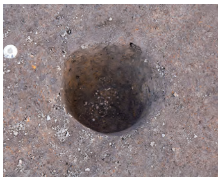
14 6号ピット 南から
