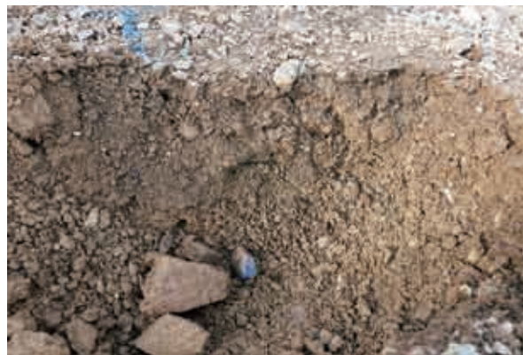
4-8 基礎部分掘削状況 (西より)
