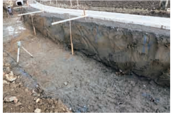
3-8 道路拡張部分土層（南西より）
