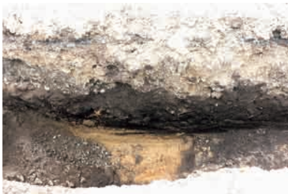
2-1 1T 西壁土層 (東より)
