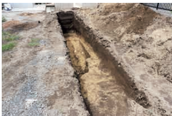
2-6 掘りこみ完掘状況（北より）
