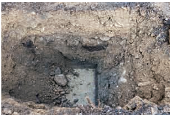
3-9 構造物撤去後土層（南より）
