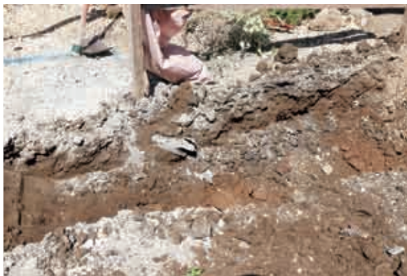
4-2 基礎部分掘削状況（北より）
