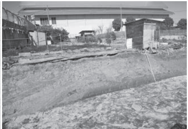
4. 北壁溜池・堤断面(南西から)
