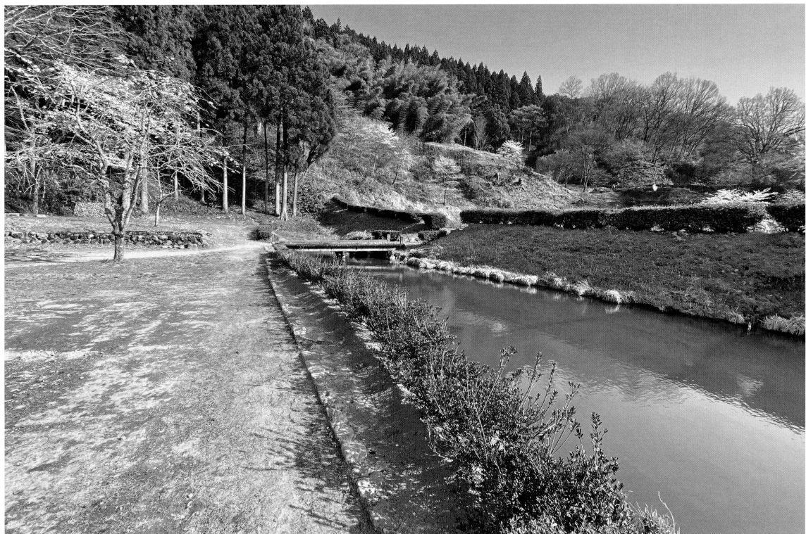
施工後（西より）
