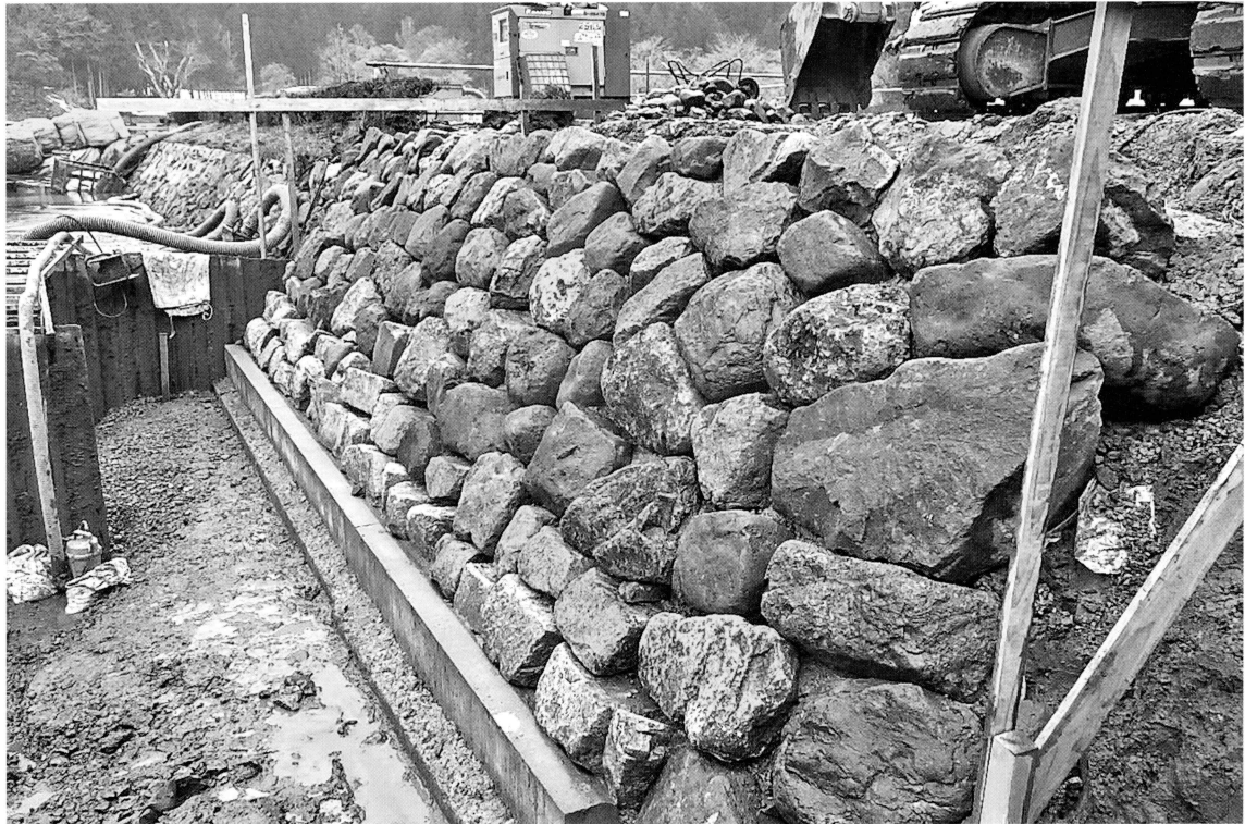
石積工の施工状況（南東より）
