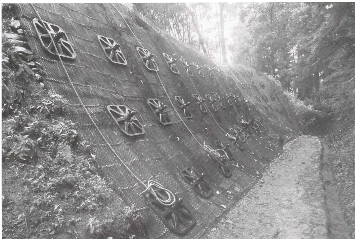
朝倉館空濠跡再整備工事 完成後（南東より）
