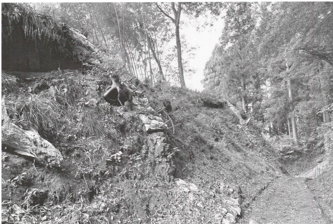
朝倉館空濠跡再整備工事 着手前（南東より）
