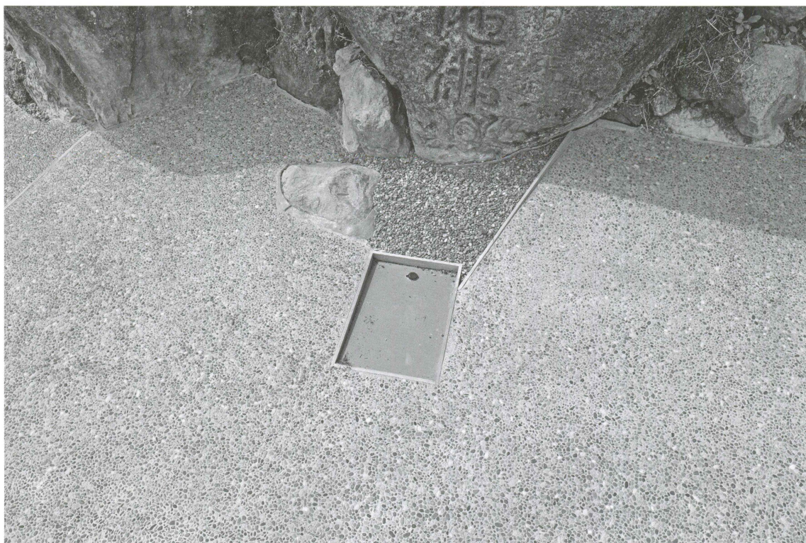
西山光照寺跡観測機器 設置後（北東より）
