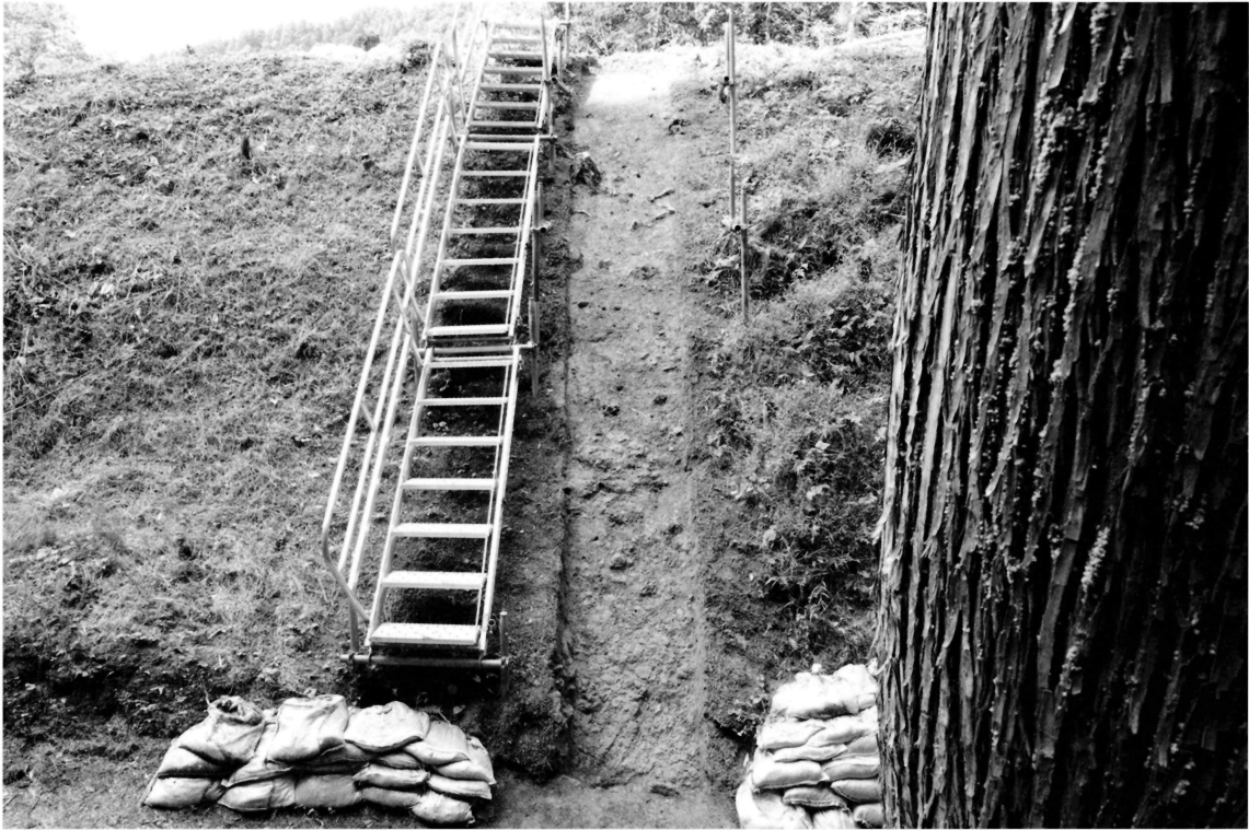
対象地①第3トレンチ全景（東より）
