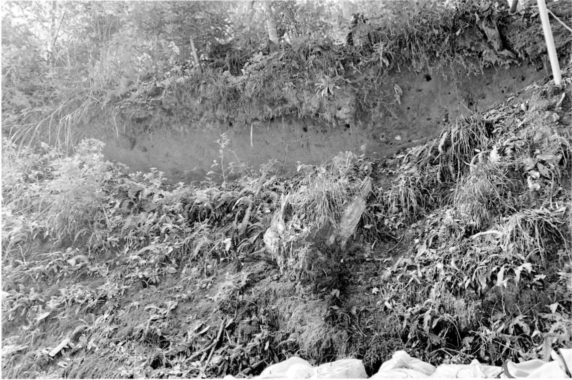
対象地の崩落状況（東より）
