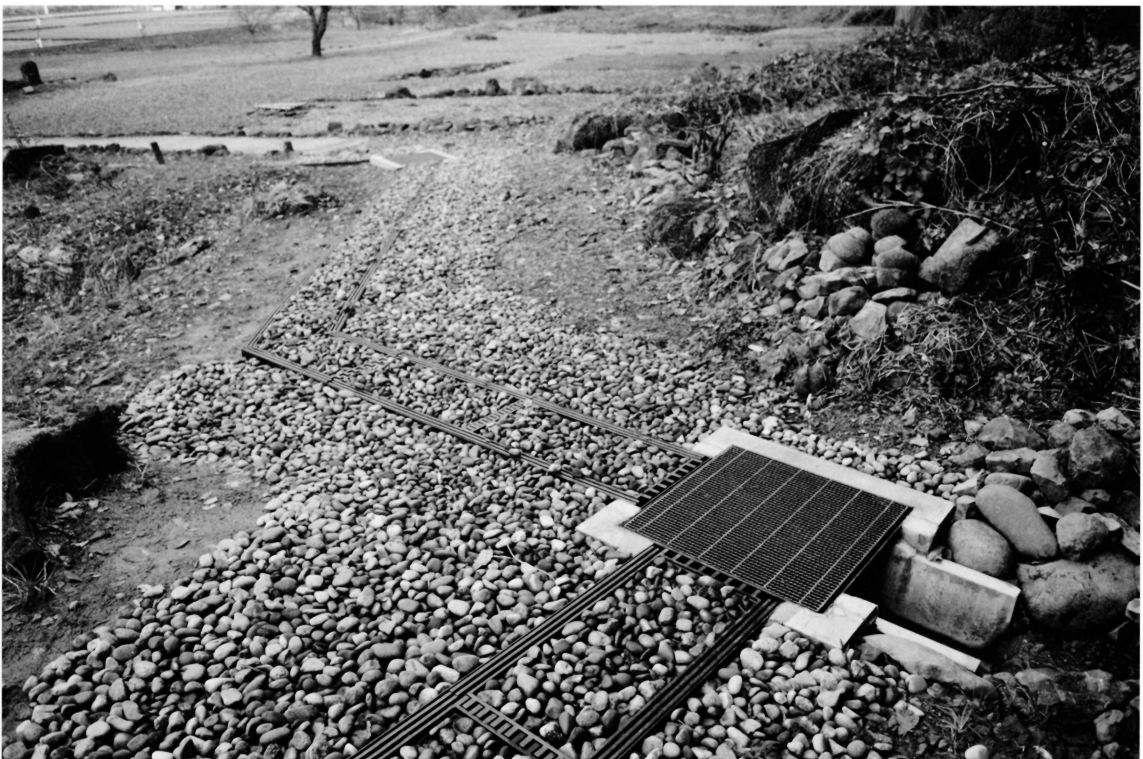
排水工 集水柵 2A（北より）
