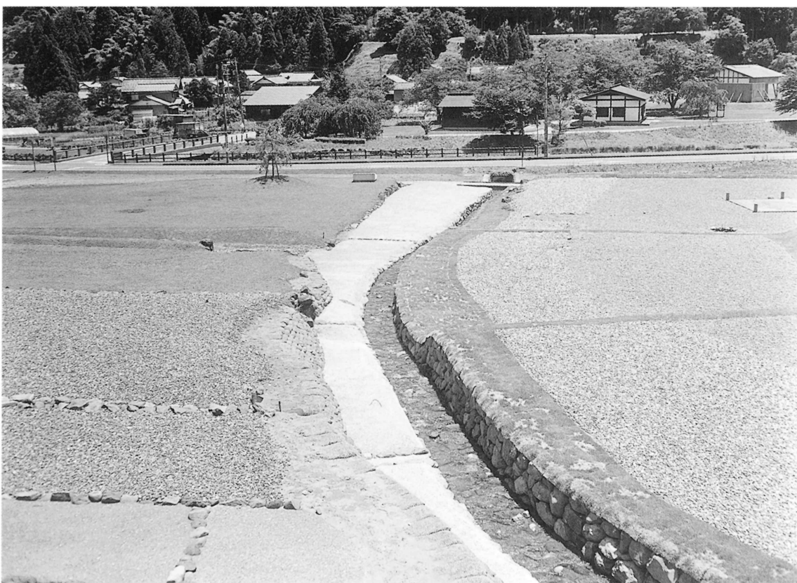
八地谷川護岸修景整備工事全景(西より)
