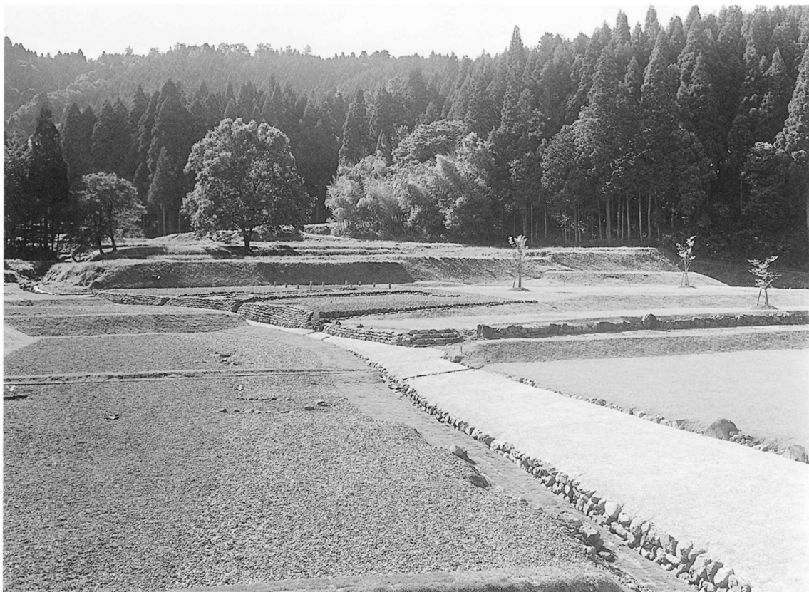
八地谷川護岸修景整備工事全景(東より)
