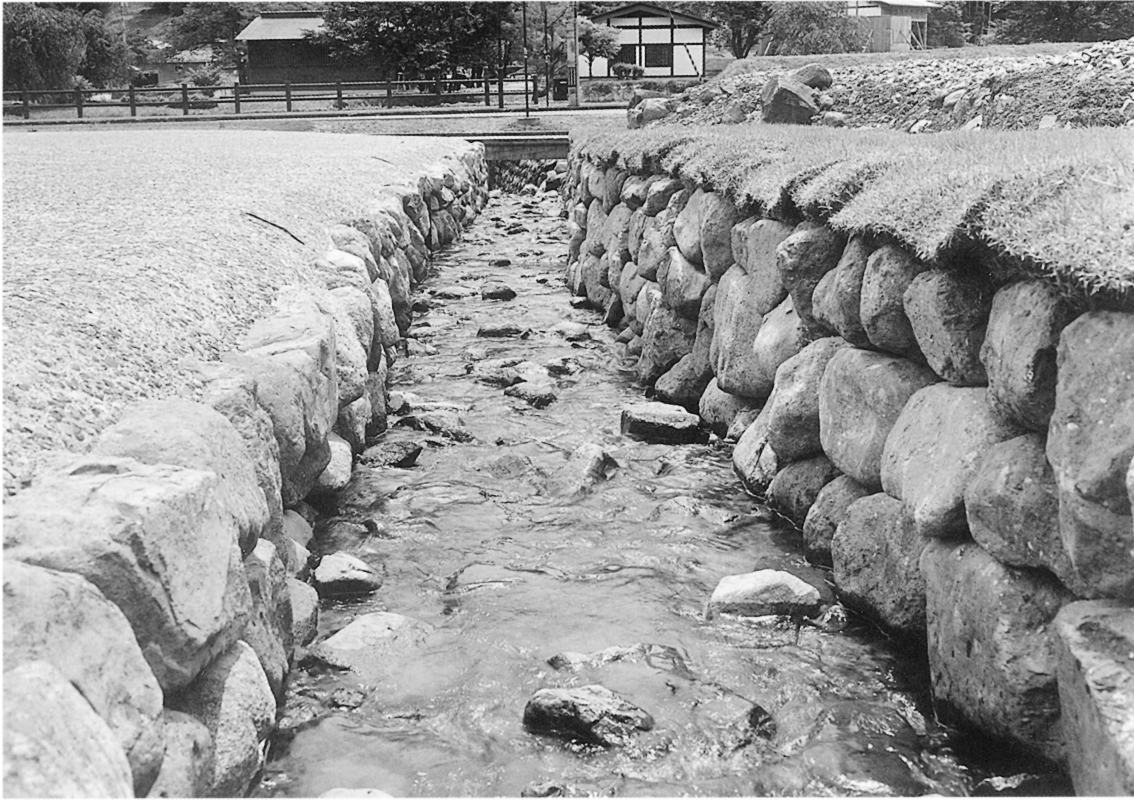
護岸工(西より)
