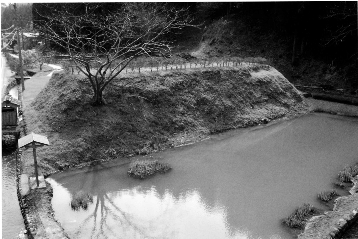
下城戸濠復旧整備工 全景（北東から）
