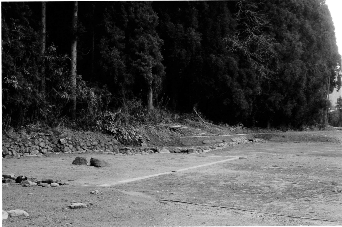
御所安養寺地区復旧整備工（北から）
