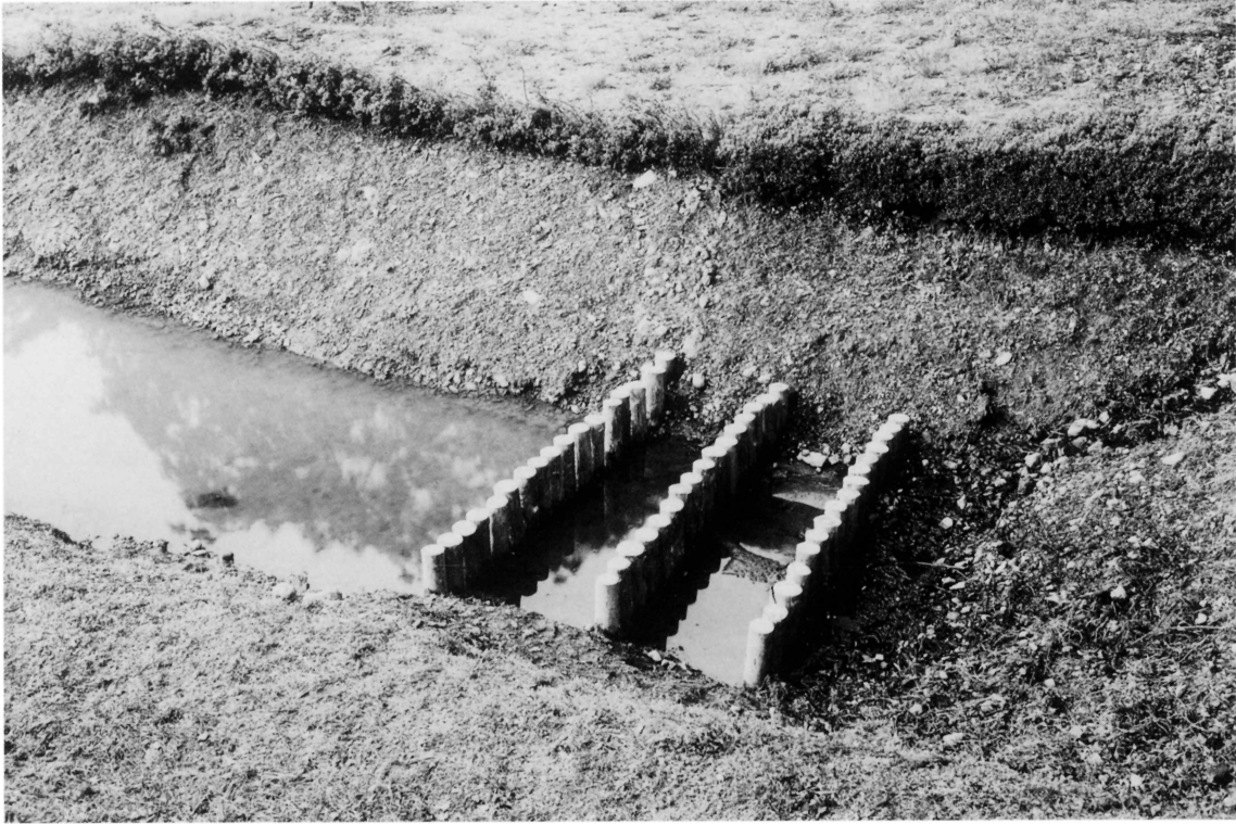
朝倉館北濠復旧整備工（南東から）
