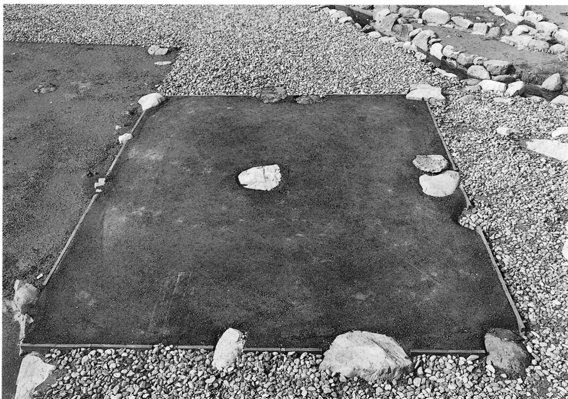
礎石建物跡SB4787整備状況(東から)
