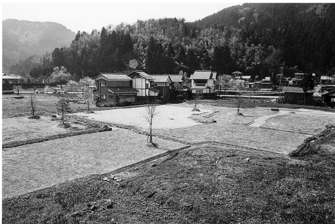
権殿屋敷跡整備状況（東から）
