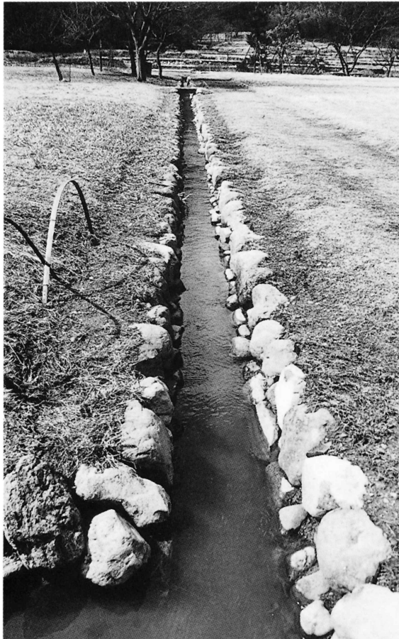
館前排水路整備状況（東から）
