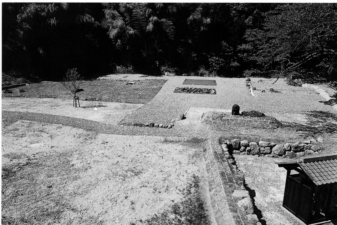
西山光照寺跡遺構復元整備工 (東から)
