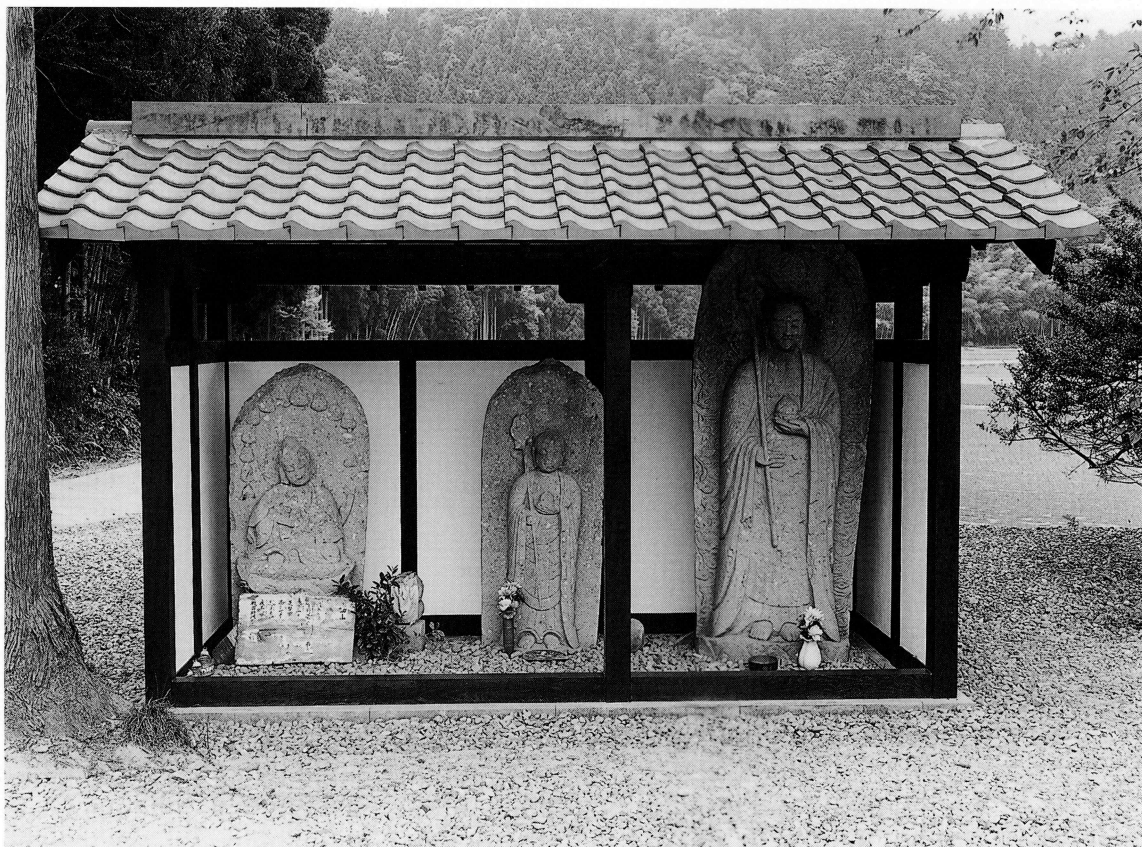
石仏覆屋整備工（B棟）（南から）
