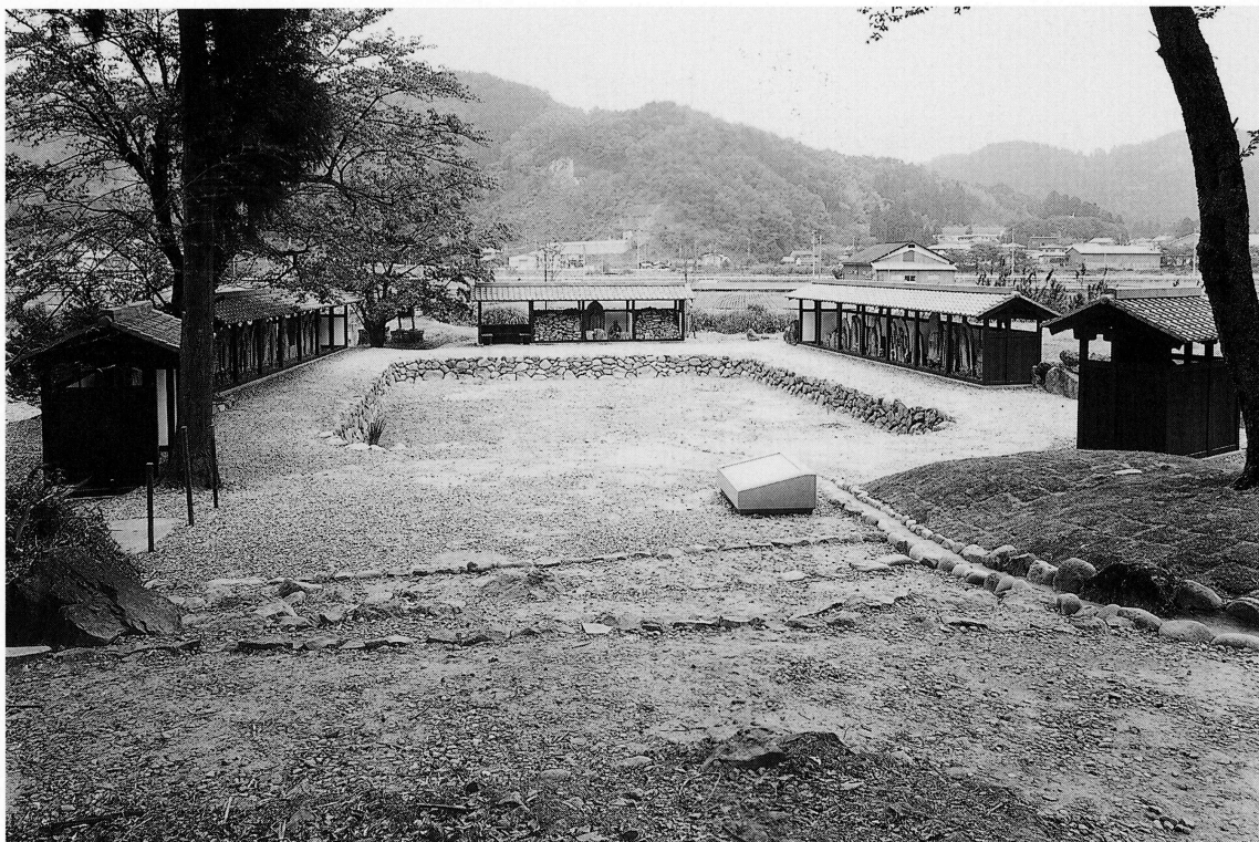
石仏覆屋整備工（西から）
