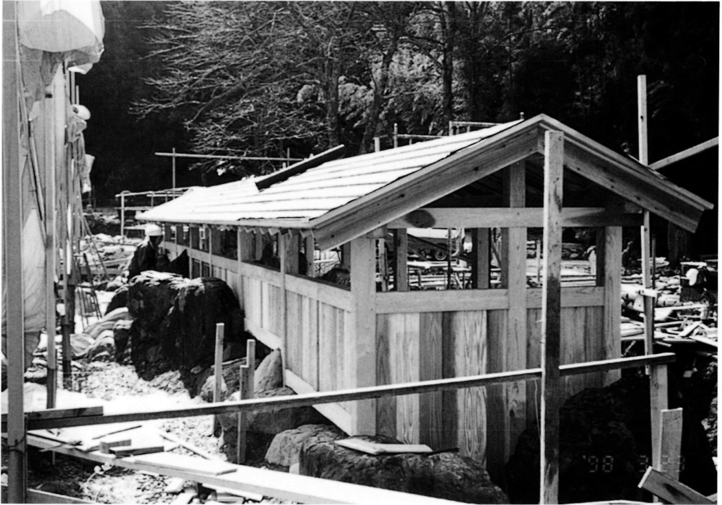
石仏覆屋D棟 組み立て状況 (東から)
