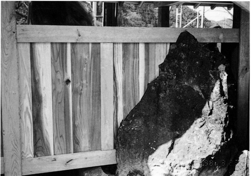
同 壁板のひかりつけ作業
