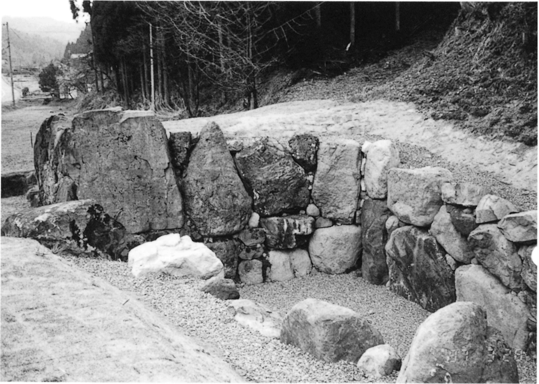
北面石垣・西石垣（北東から）
