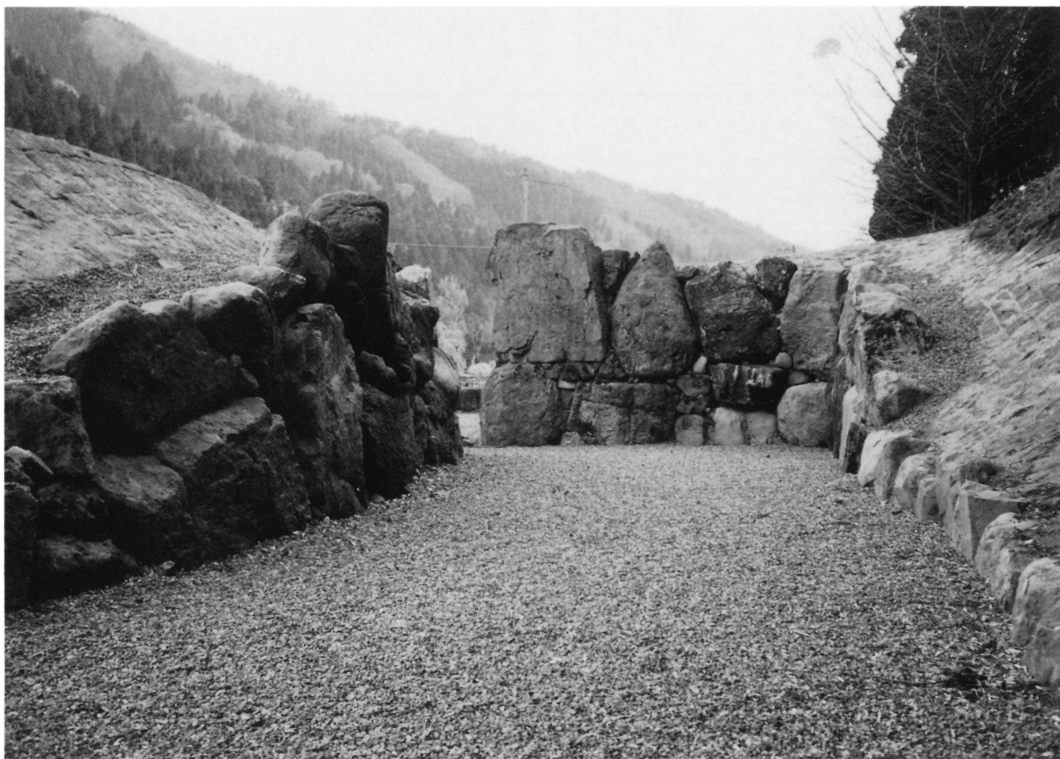
東土壘石垣・北面石垣
