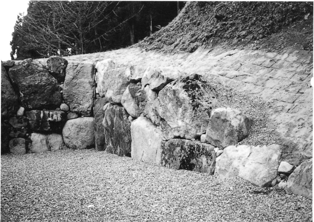
西石垣（北東から）
