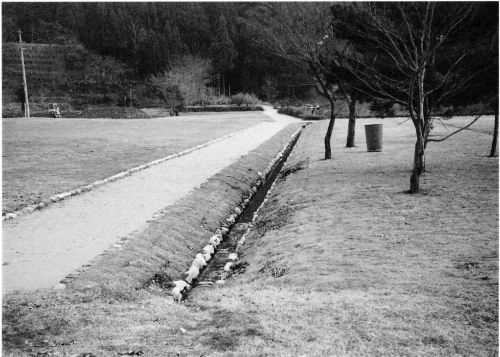
園路及び排水路 (西から)
