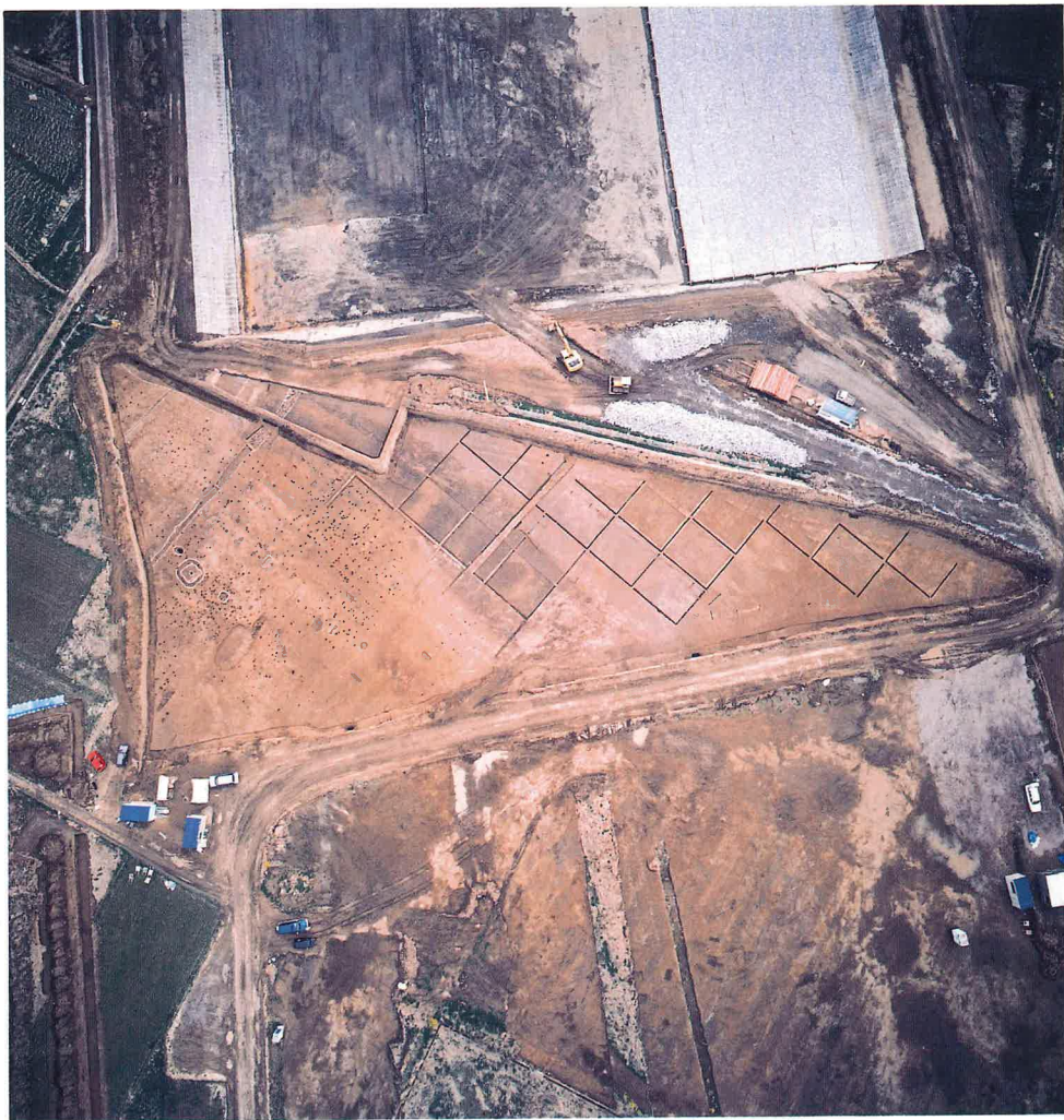
八坂本庄遺跡 A区全景（真上から）
