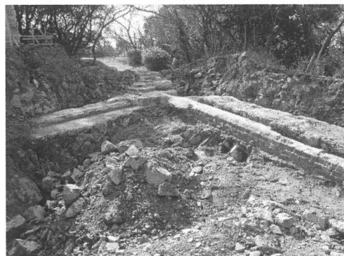
出土した建造物の基礎 (生石山堡壘)
