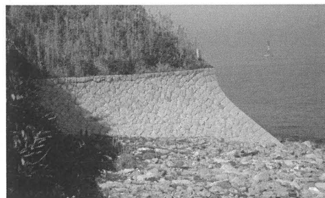
高崎台場（石垣北西隅：北から）
