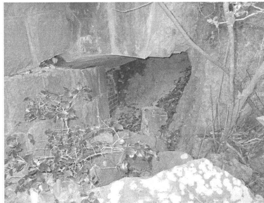
砲側庫と思われる施設（北東から）
