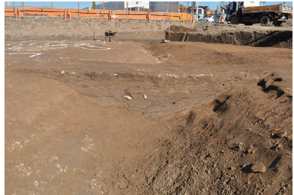
第27号溝跡東側溝土層断面
