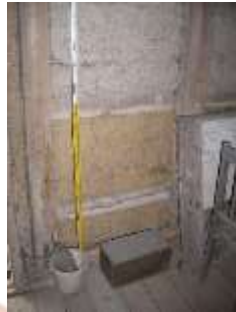
被災水位のわかる土蔵(荒井新田)
