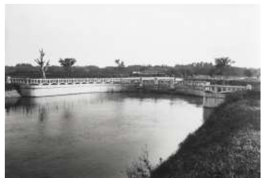
柴山伏越（昭和の改修後）
