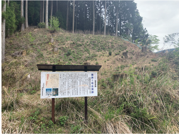
1号窯跡現況（近景）
