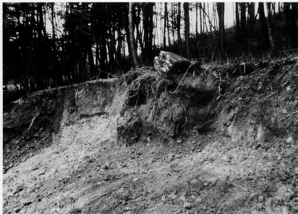
2. 開削状況（南より）
