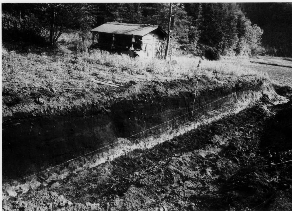
2. トレンチ状況
