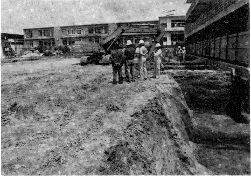
工事のための基礎掘りで地山が確認された
