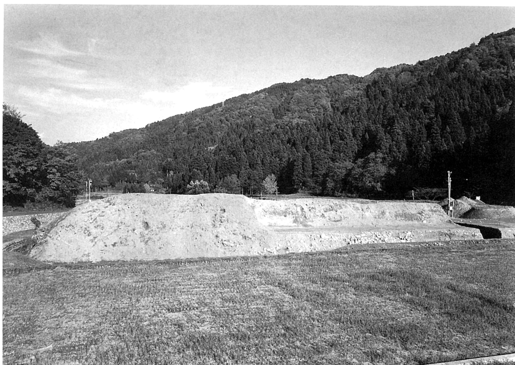
上城戸全景 (南から)
