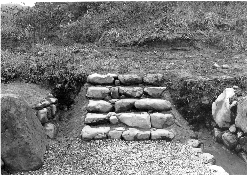
昇降用石段 (南北方向道路から)
