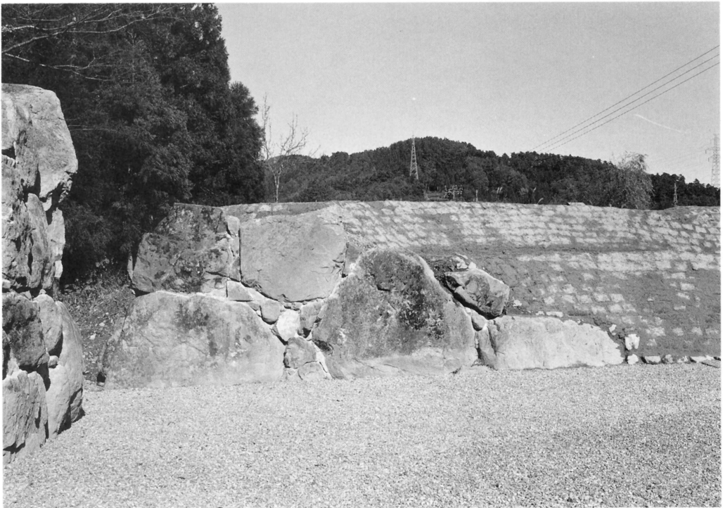
城戸口南面石垣 (南から)
