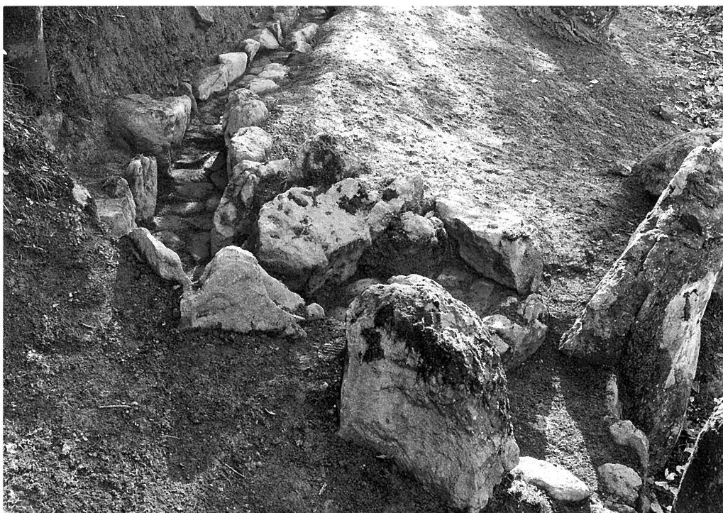
湯殿跡庭園導水路 (滝口付近)
