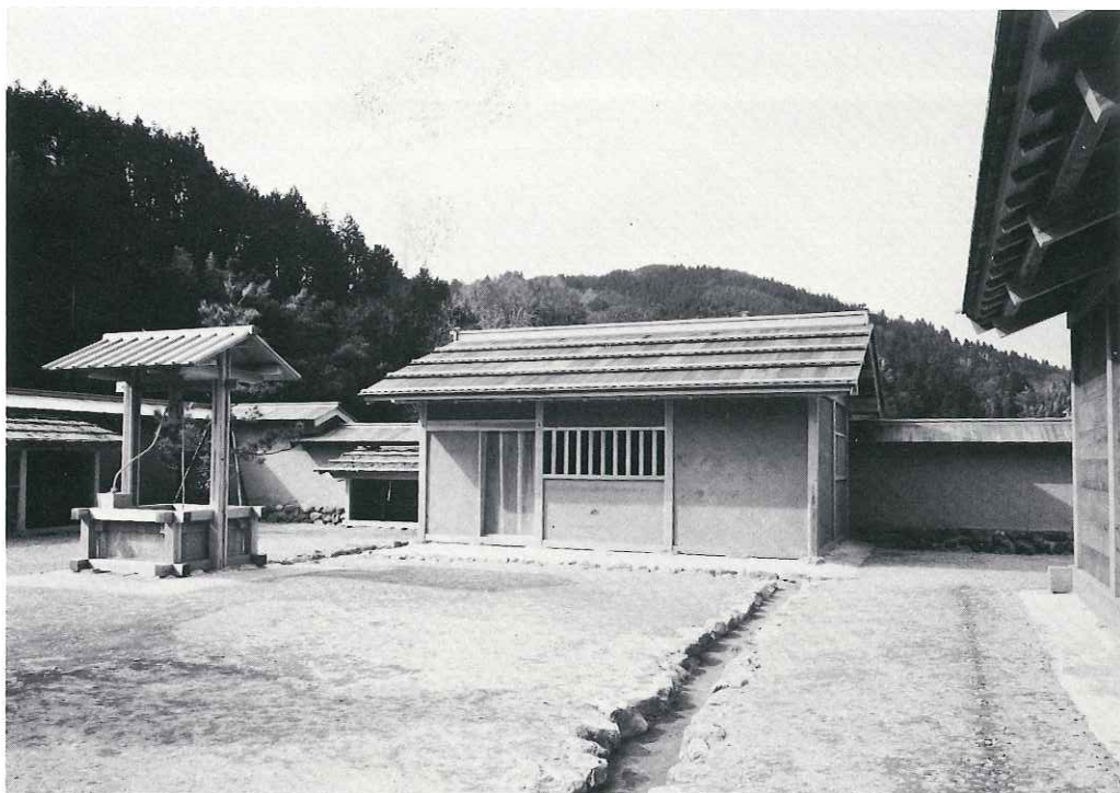
使用人小屋 (東南から)
