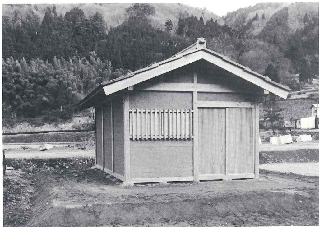
消火ポンプ小屋 (西から)
