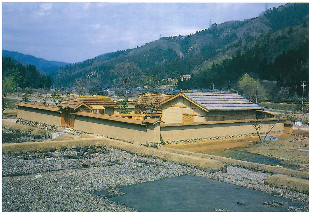
復原武家屋敷全景 西南から
