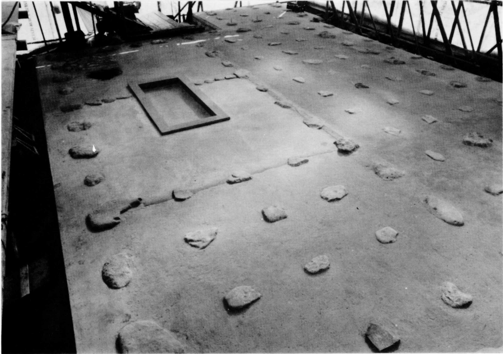
礎石据付状況 西北から
