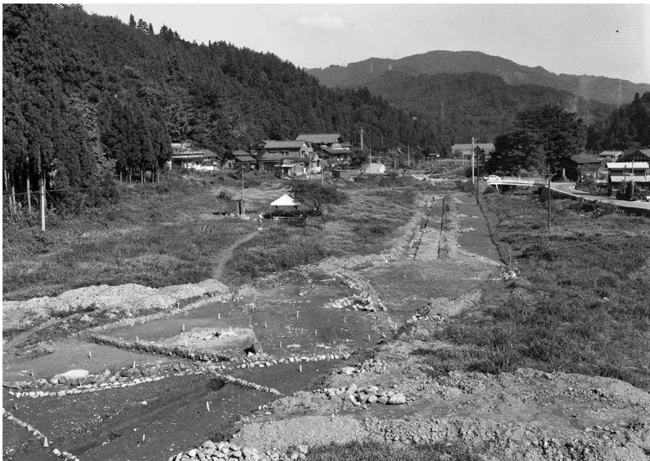
(4) A・D区遠景（南から）
