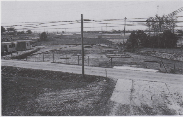
F区全景（東から）
