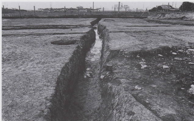
第7号溝跡 (F区)
