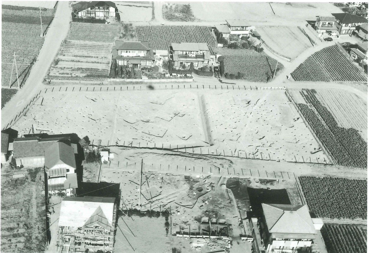
C区・D区全景（南より）
